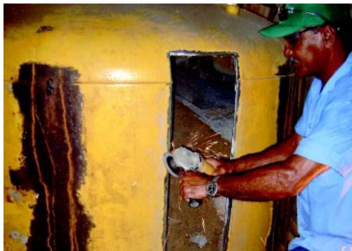
Reforma total dos filtros de todas as piscinas (uma olímpica, uma social e duas infantis)
