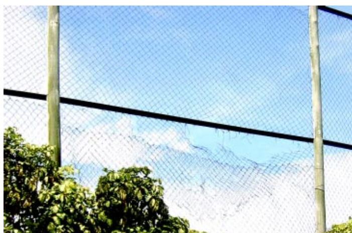
Reforma do alambrado aos fundos do campo de futebol
