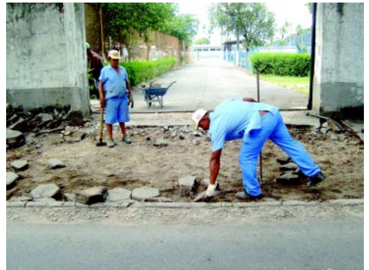
Construção do portão nº 2 do Clube, para entrada de carga
