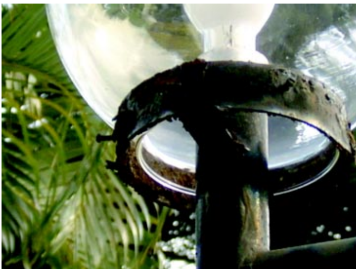
Recuperação e pintura dos postes dos jardins
