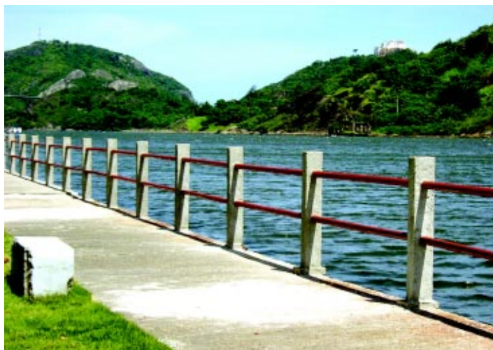
Reconstrução do alambrado da orla
