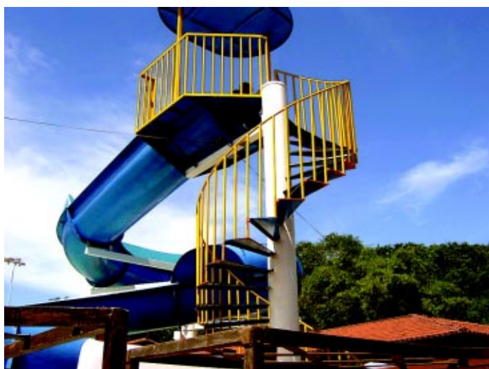
Pintura de todo o Parque Aquático e manutenção dos toboáguas
